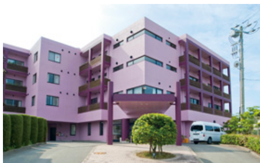
介護老人保健施設赤門なのはな館
